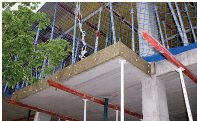
Panel compuesto por un estrato de 10 mm de espesor de viruta gruesa de madera de abeto, aglomerado con cemento Portland gris, firmemente adherido a otro estrato de poliestireno ignífugo.
